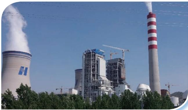
由鍋爐公司提供鍋爐設備的華能集團萊蕪電廠百萬千瓦超超臨界二次再熱燃煤發電機組，經過半年試生產期，完成各項性能考核試驗，機組各項環保指標全面優於國家超低排放限值，成為目前世界上效率最高、能耗最低、指標最優、環保最好的火電機組，一舉成為世界綠色煤電的標杆機組。
