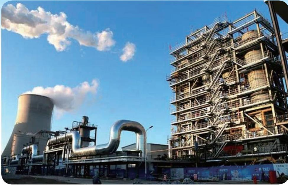
由鍋爐公司總承包的國家首台生物質耦合發電示範項目——大唐長山660MW超臨界燃煤發電機組耦合20MW生物質發電示範項目順利通過了168小時試運和性能考核試驗，各參數達到設計要求，壓塊秸秆正壓氣化的效率和系統耗電率指標均達到較高水平。該機組順利通過性能考核試驗，標誌著國家首台生物質耦合發電示範項目獲得圓滿成功，填補了國內生物質微正壓循環流化床氣化技術空白，摸索出了針對不同生物質燃料特性的運行經驗和壓塊秸秆氣化爐輸灰與排渣設計基礎數據，為生物質耦合發電的全國推廣奠定技術基礎，也將為地方生物質能源開發利用、周邊區域環保工作及經濟發展產生積極影響。
